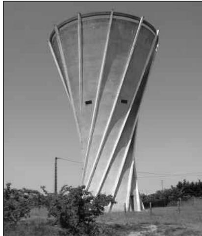
*Pour l'hyperboloïde à une nappe, l'existence de ces génératrices assure en architecture la rigidité du solide permettant d'utiliser cette forme pour des châteaux d'eau ou des tours de refroidissement.*
