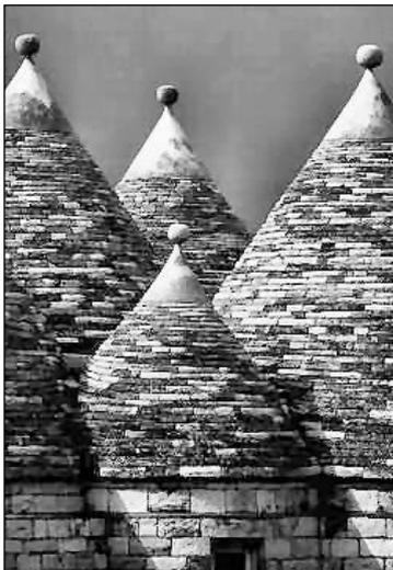
*On dispose des rangées de pierres successives ; chaque rangée débord légèrement par rapport à la rangée inférieure, si bien que les deux parois se rapprochent. On ferme l'ensemble avec un simple rangée de dalles.*
